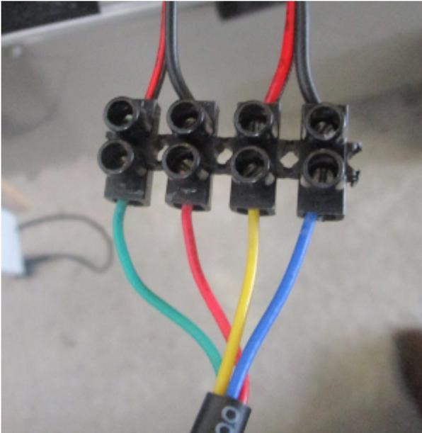
Puis câbler l'alimentation moteur de chaque étage moteur : utiliser du câble 1.5mm<sup>2</sup> de section.
